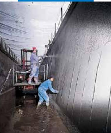
Canal hidroeléctrica Bertini - Robbiate (Como) - Italia: terminando con llana
