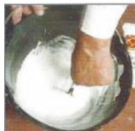
2. Usar 1 parte de agua en 2.5 partes de pastina y mezclar hasta obtener una pasta.
