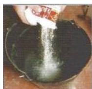
1. Colocar el agua en el balde de albañil y posteriormente el mortero para el tomado de juntas.
